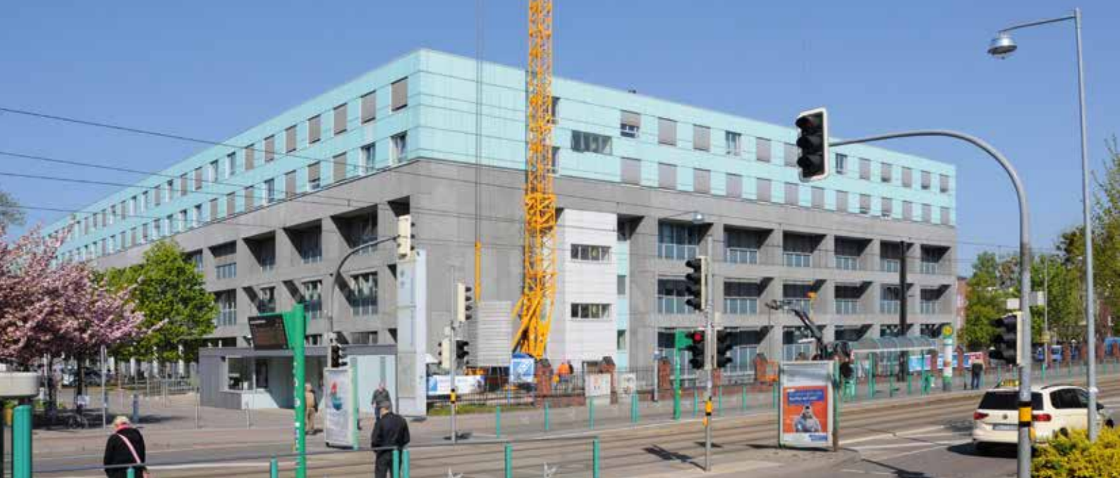
Anbau des Aufzugsbereichs an der Ostfassade am Haus 60a
