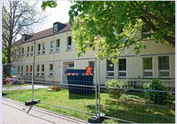
In den nächsten Monaten ist die Kita des Uniklinikums im Fermersleber Weg eine Baustelle.
